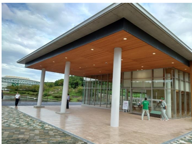
①西口休憩所入口
